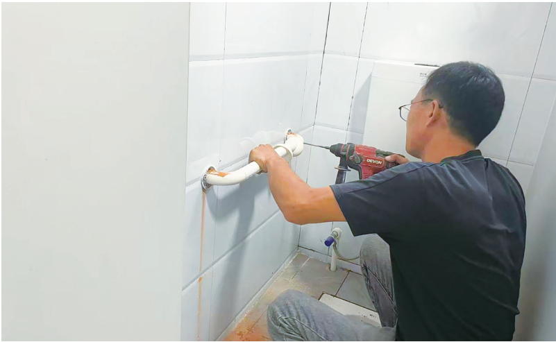
■施工人员在公共卫生间蹲位旁加装扶手。
