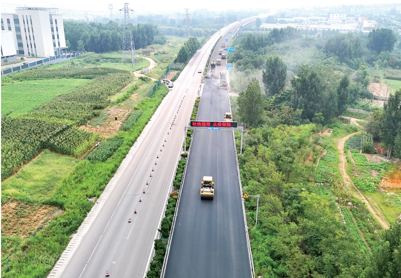
■G104京岚线济南泰安界至满庄段施工现场。 记者 李腾腾 摄
