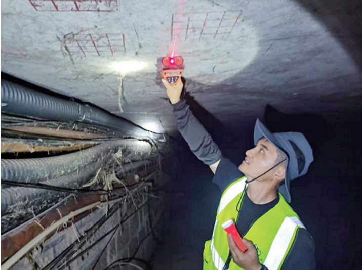
■工作人员排查路桥隐患。
