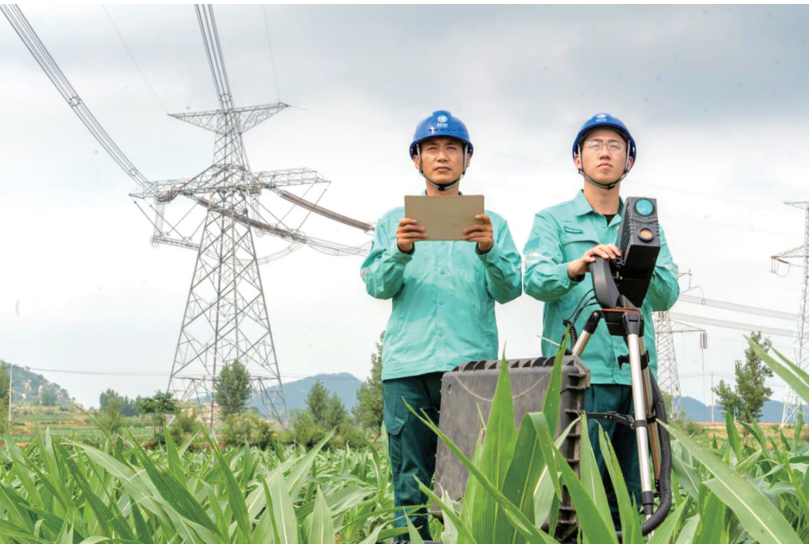
■运维人员利用激光清障仪(激光炮)清除800千伏昭沂线导线异物。 通讯员供图
