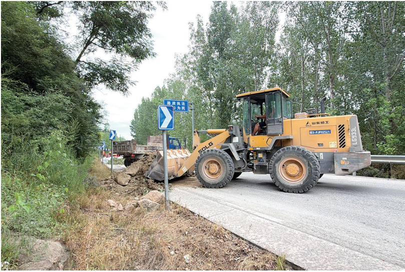
■演练机械设备清除路面障碍。 通讯员供图
