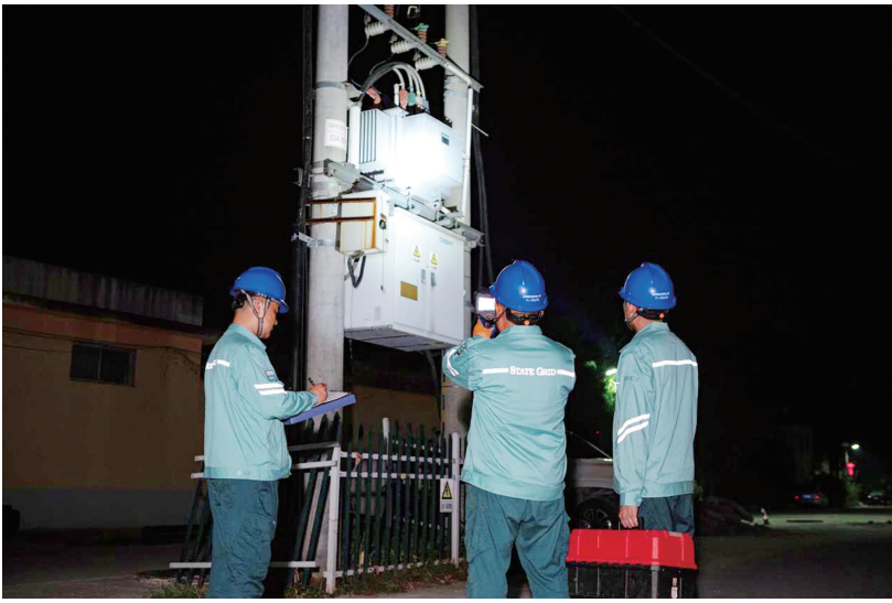
■工作人员对10千伏铁东线夏家庄台架跌落开关等重要节点开展夜巡带电检测。 通讯员供图
