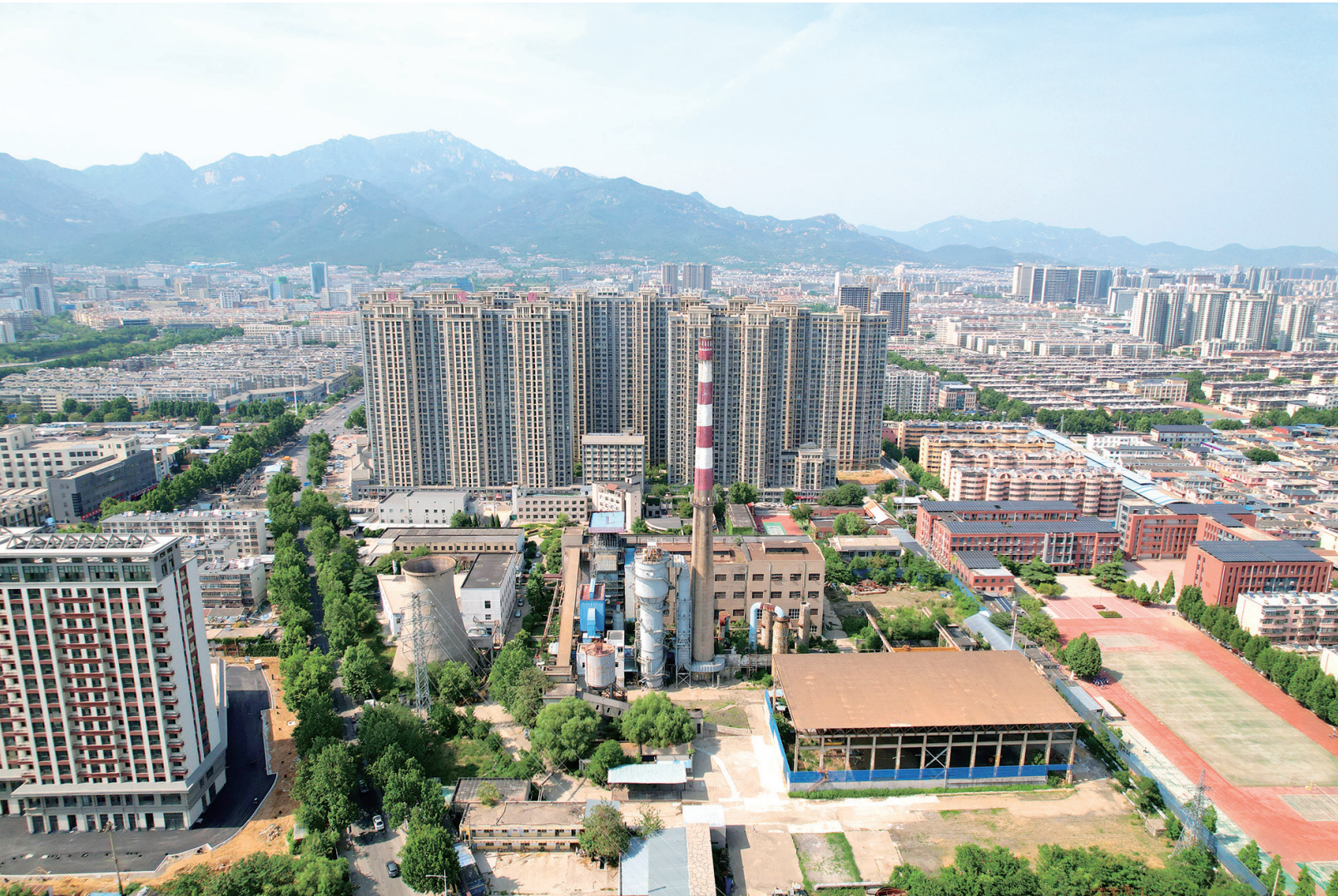
泰山城建热电厂工业遗址提升改造项目。
