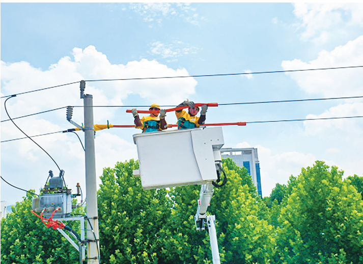
■施工人员开展带电消缺作业。
