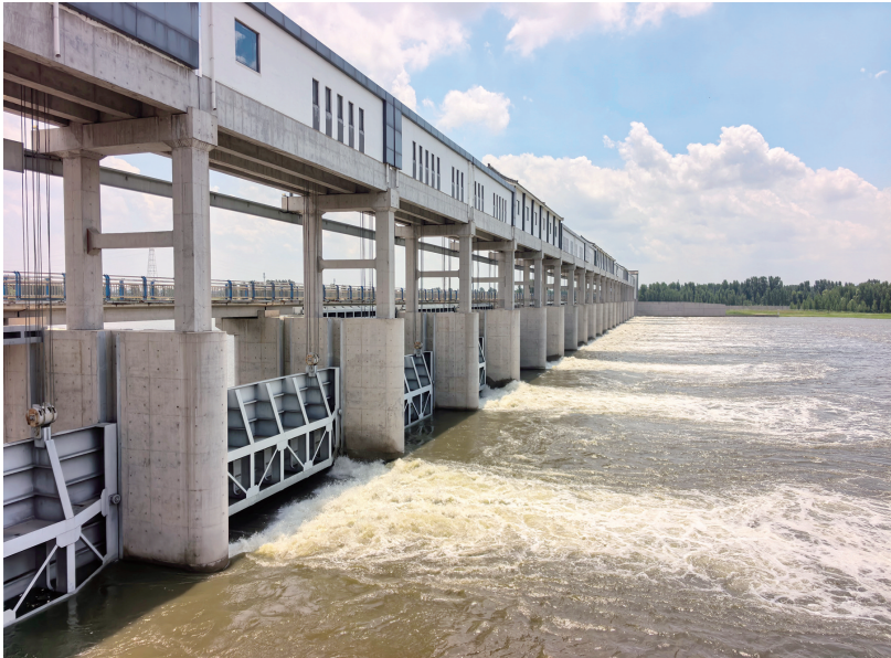
■汶口坝拦河闸提闸泄洪。
