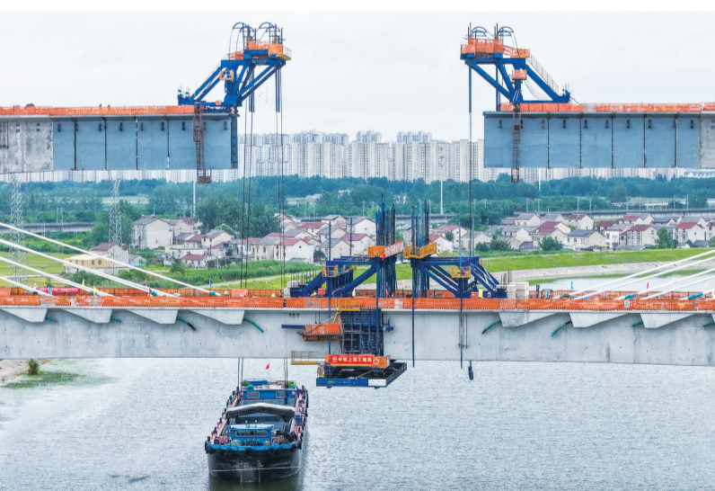
这是6月30日拍摄的宁淮城际铁路跨滁河矮塔斜拉桥（前）施工现场（无人机照片）。6月30日，随着最后一段主梁混凝土浇筑完成，由中铁上海工程局承建的新建南京至淮安城际铁路（简称“宁淮城际铁路”）全线跨度最大的跨滁河矮塔斜拉桥顺利合龙。跨滁河矮塔斜拉桥位于江苏省南京市六合区，是宁淮城际铁路六合特大桥的核心区段，大桥主梁总长521.7米，主跨达220米。
