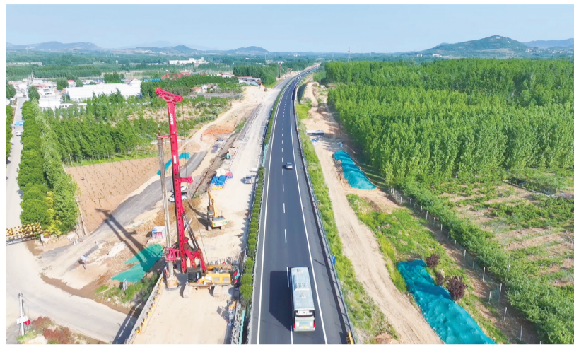
■泰新高速左幅封闭施工现场。 记者 温雯 摄
