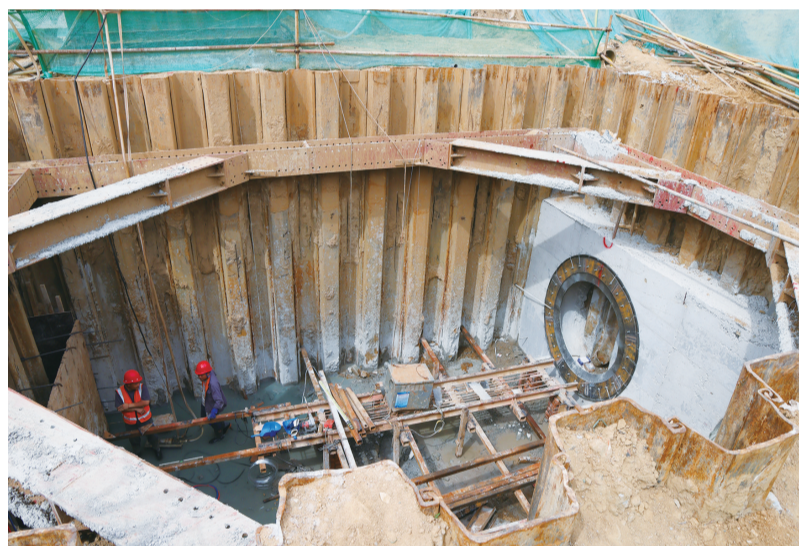
■管网施工现场。
