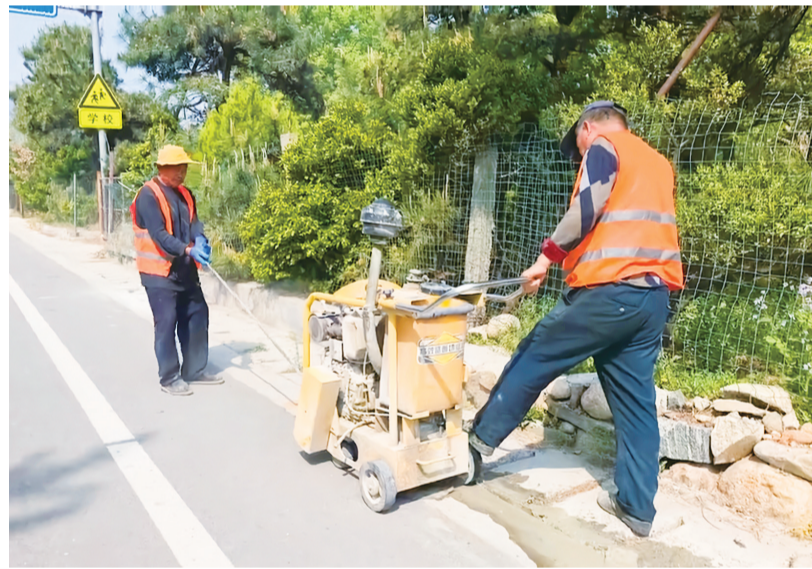
养护人员更换破损排水沟盖板。 通讯员供图
