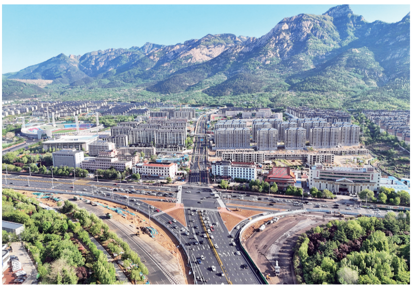
东岳大街与长城路交叉路口全面拓宽,主干道已正式具备通车条件。
