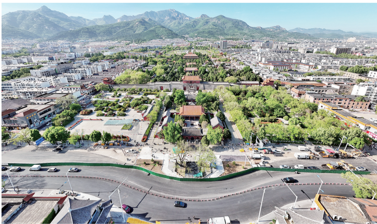
■4月20日,石材铺装及绿化工作已完成,正在进行最后的养护。
