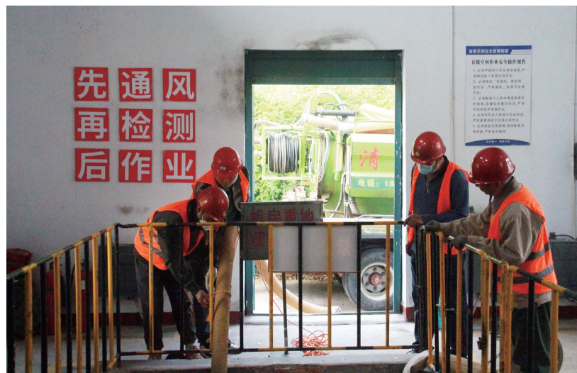
■工作人员开展清淤作业。
