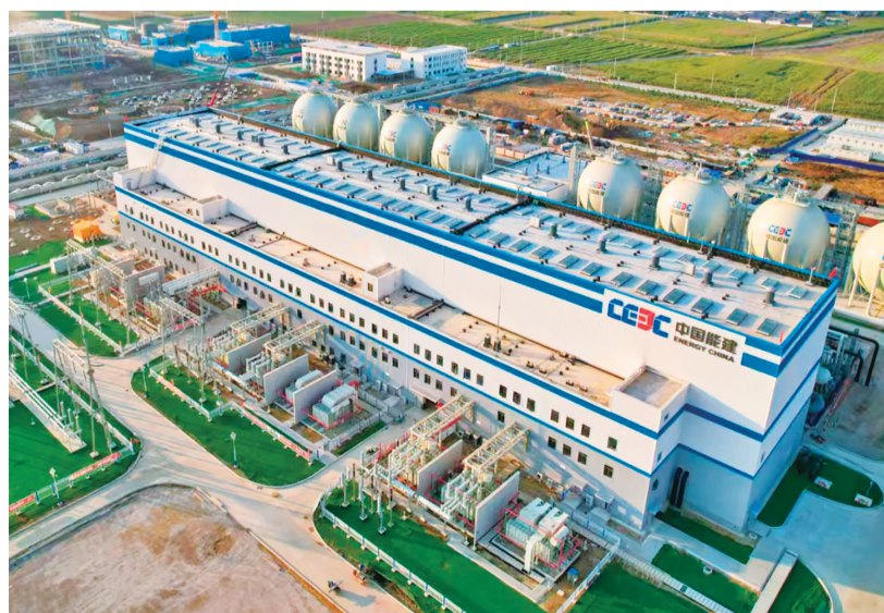
■中电建350MW盐穴压缩空气储能项目现场。 通讯员供图
