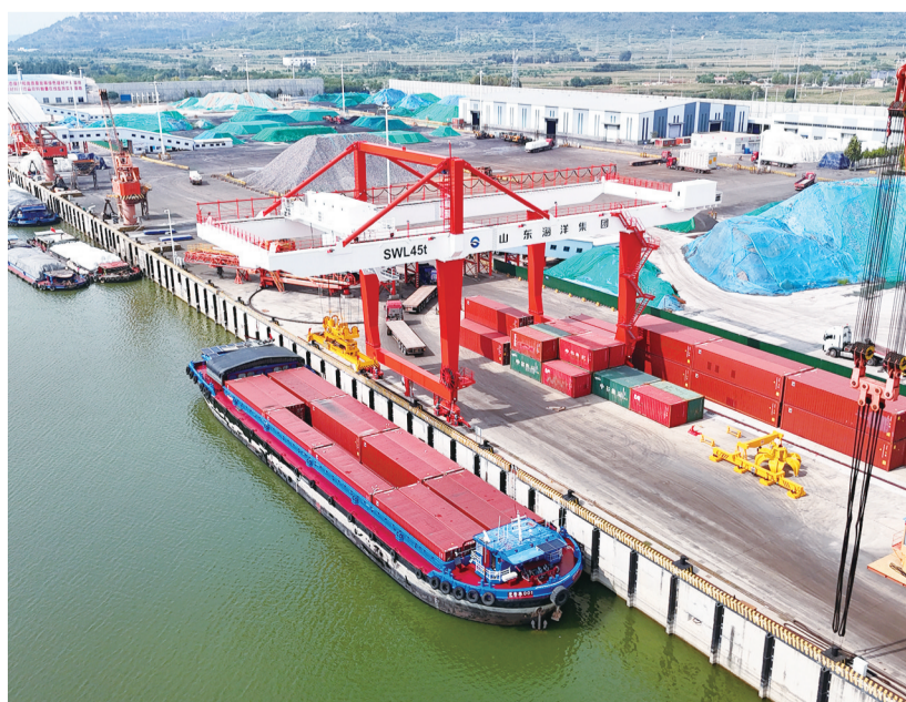
■泰安港东平港区老湖作业区码头。
