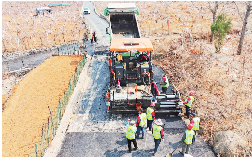
■环白云山路施工现场。
