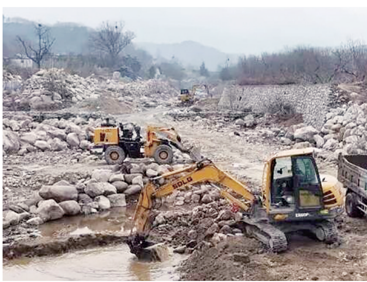
施工现场。 通讯员供图
