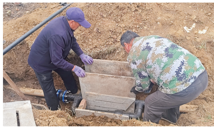
■工人进行管道施工。 通讯员供图
