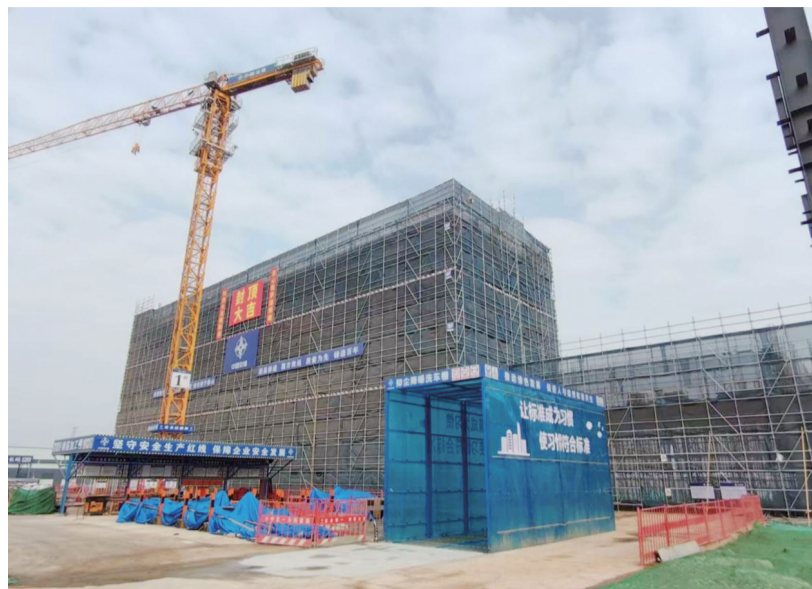
■深蓝航天液体火箭发动机增材制造基地项目新厂区建设中。 通讯员供图
