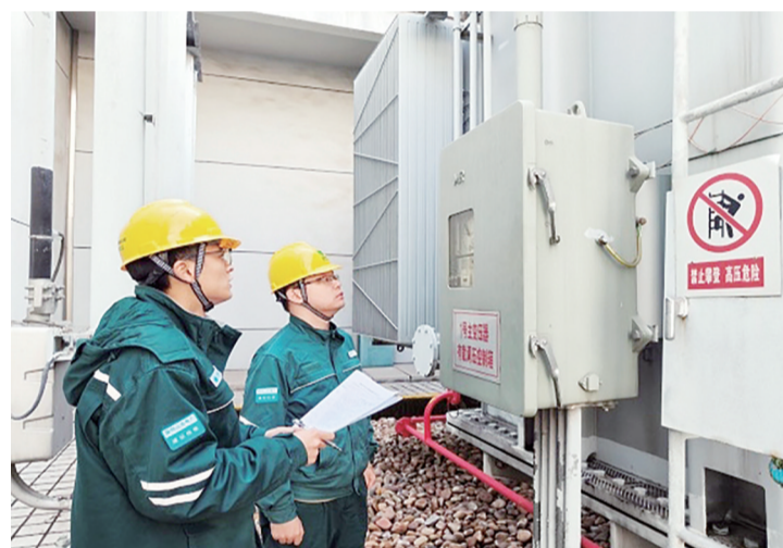
工作人员排查供电安全隐患。 通讯员供图
