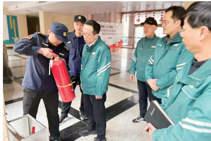
工作人员检查消防器材。 通讯员供图
