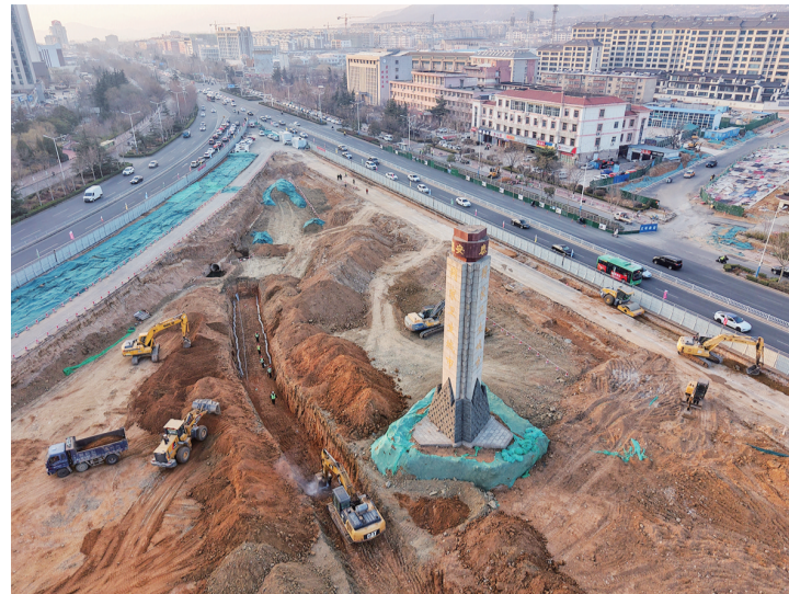
施工现场。记者 陈阳 摄
