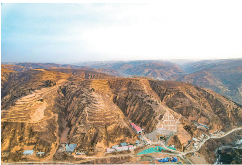
1月27日拍摄的延榆高铁金家沟隧道(无人机照片)。
