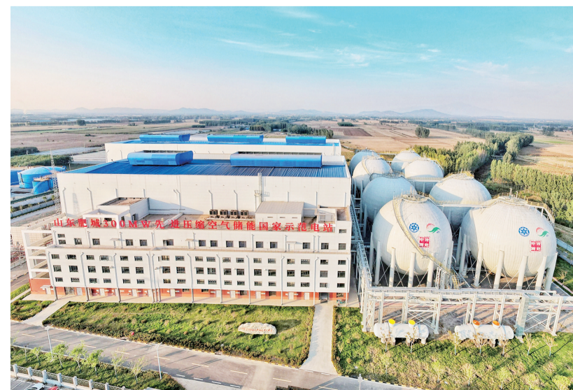
■肥城300MW先进压缩空气储能国家示范电站。
