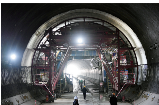
这是1月21日拍摄的漳汕高铁马金山隧道。
