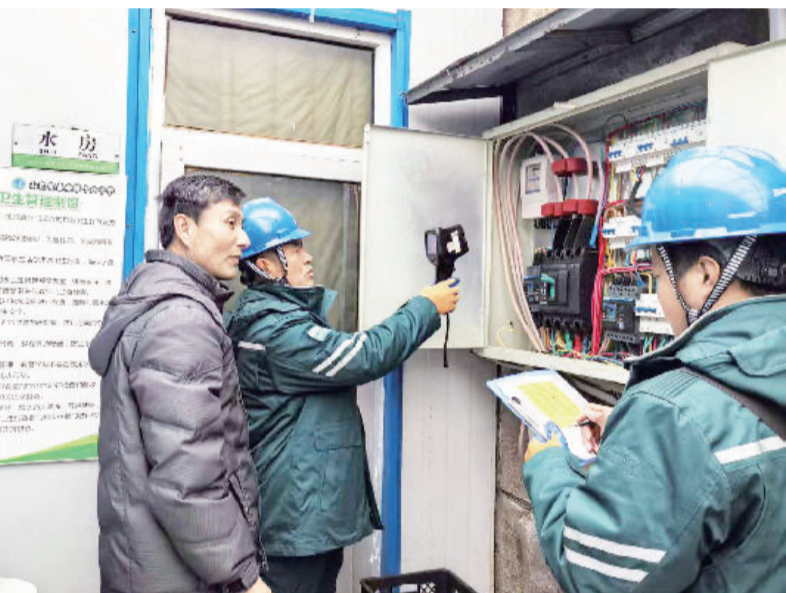
工作人员开展用电检查与隐患排查。 通讯员供图
