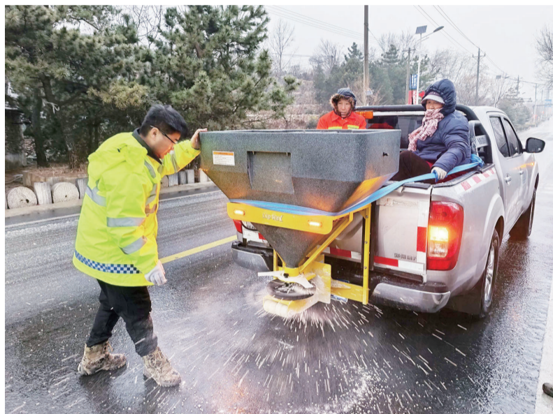
工作人员对重点路段撒布融雪剂和防滑剂。 通讯员供图
