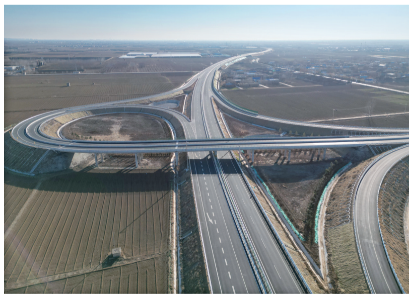
济微高速宁阳段。 通讯员供图
