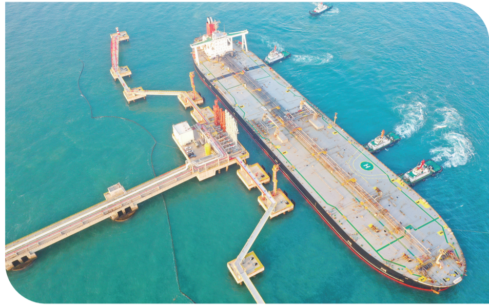
12月18日，一艘装载着17.9万吨石化原辅料的船舶泊入国投洋浦油储码头30万吨级原油泊位(无人机照片)。
