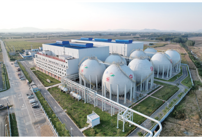
■山东肥城300MW先进压缩空气储能国家示范电站。 记者 陈阳 摄
