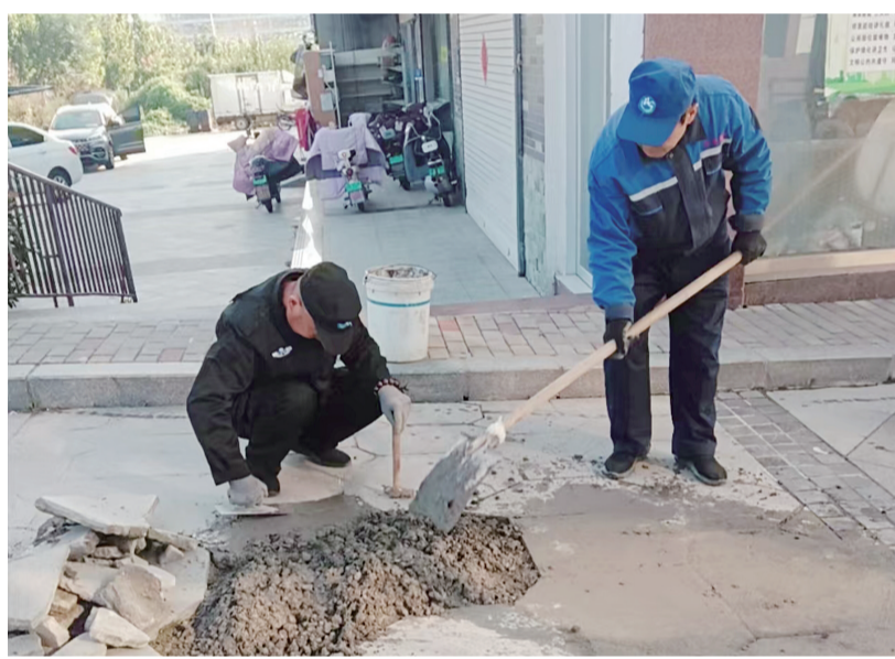
■志愿者修复破损路面。 通讯员供图
