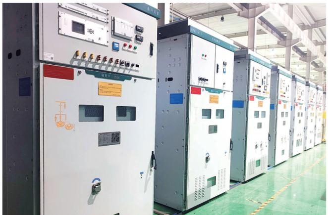
■KYN61-40.5(Z)/4000-40大电流金属封闭开关设备。 通讯员供图
