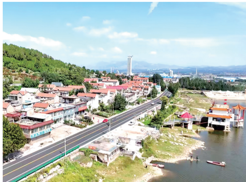
■S241临徐线新泰市寺山段。 通讯员供图 公路部门提前制定临时交通疏导方案,通过在施工路段周边关键节点设置清晰绕行标识、安排专人现场引导交通等措施,保障了施工期间区域交通的平稳有序。
