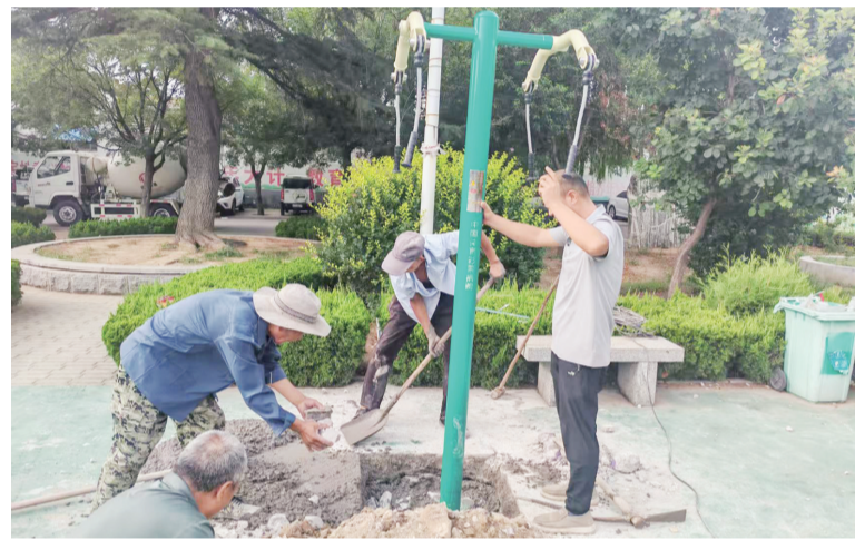
施工人员安装健身器材。
