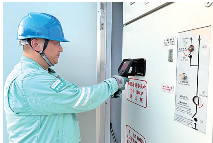
工作人员开展安全巡视工作。 通讯员供图
