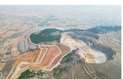
泰安市三山、三股山片区废弃矿山生态修复项目现场。
