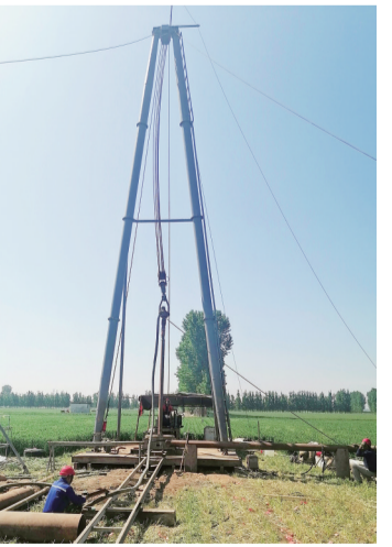
肥城市安驾庄地热田地热资源调查评价项目施工现场。
