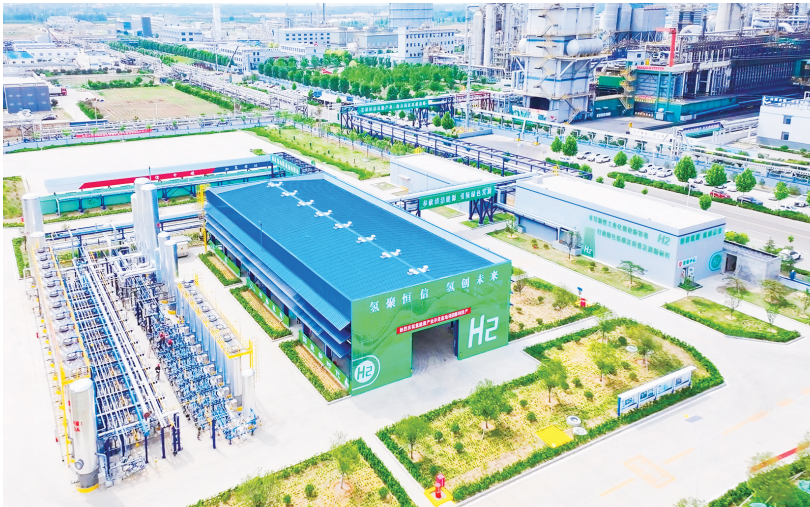
■恒信高科万吨级氢能源产业示范项目。
