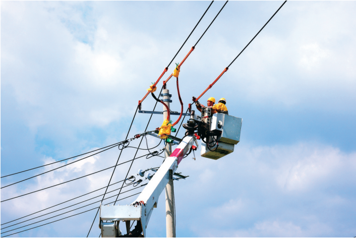
■工作人员高空作业保供电。
