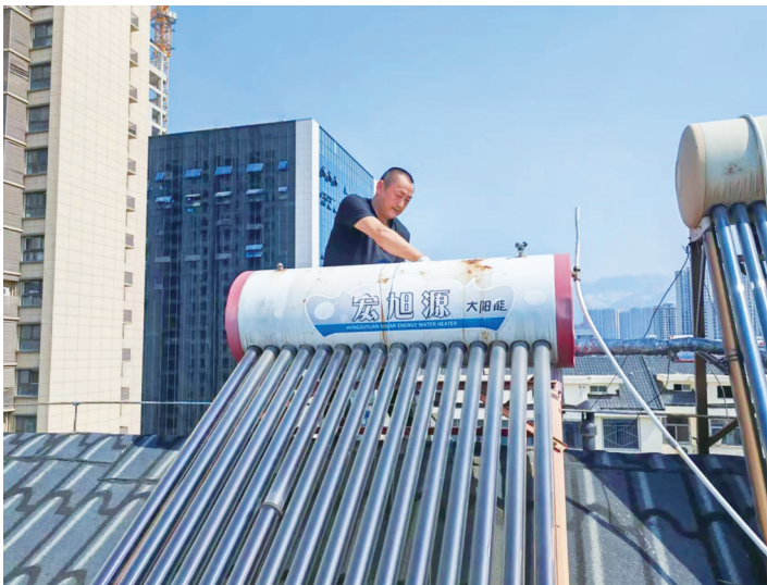
■工作人员加固松动的太阳能热水器。
