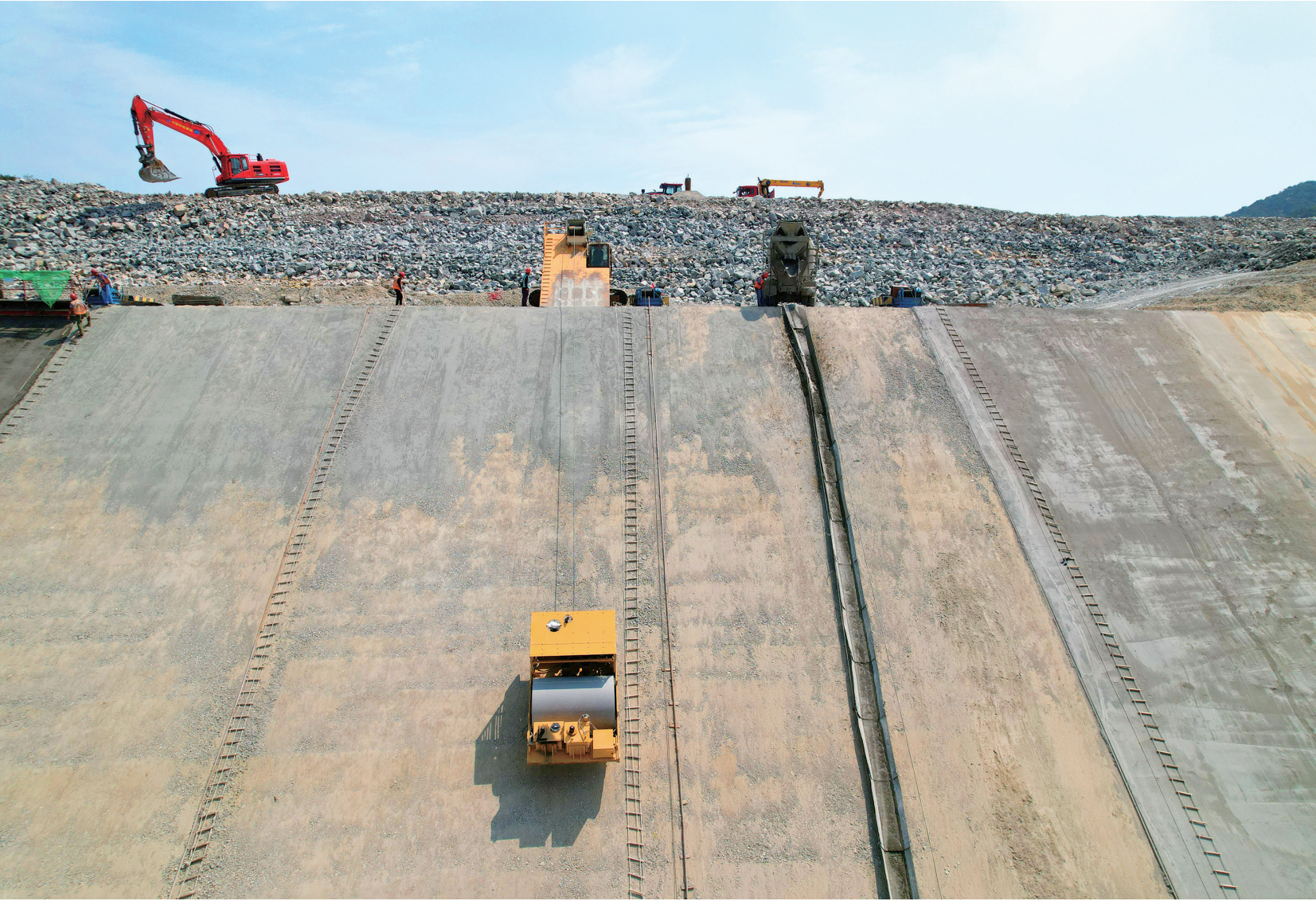
上水库施工现场,斜坡碾在坡面上来回碾轧。
