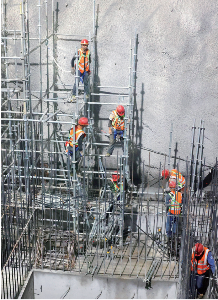
施工人员在地下厂房搭建脚手架。
