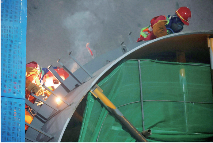
工作人员焊接检修通道组件。
