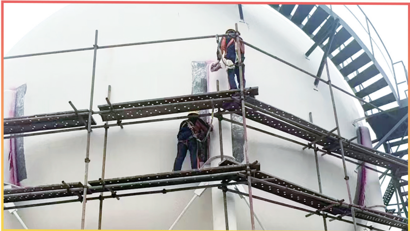
市质特检院检验人员对球罐开展检验
