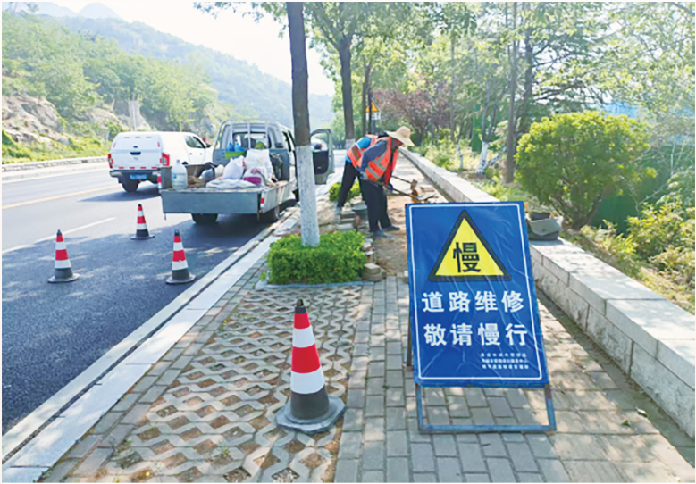
■施工人员整修路面。
