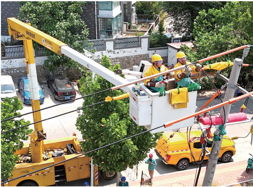
■工作人员进行带电接火作业。
