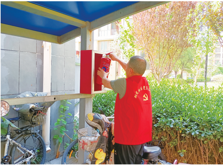
■工作人员更换灭火器。
