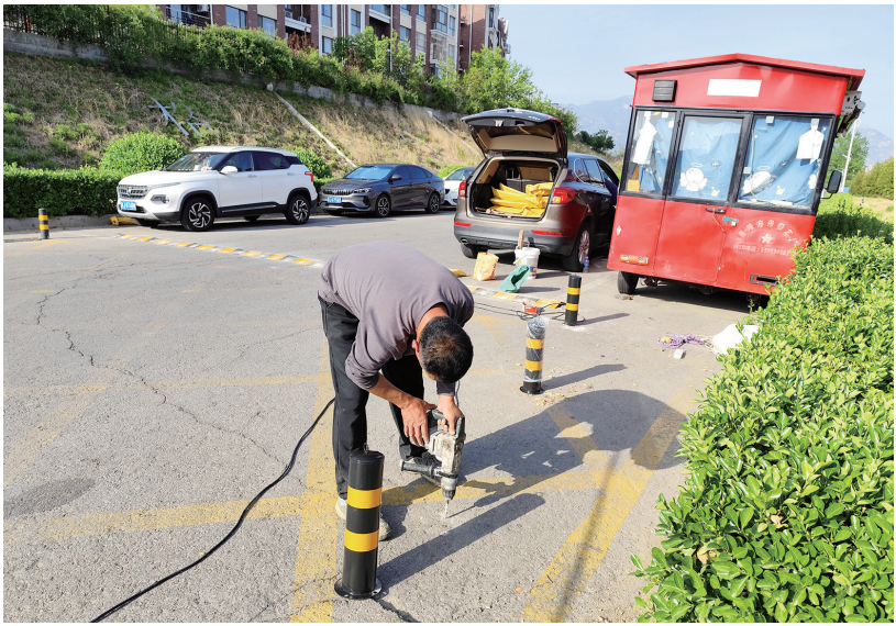
■工作人员安装阻车桩。
