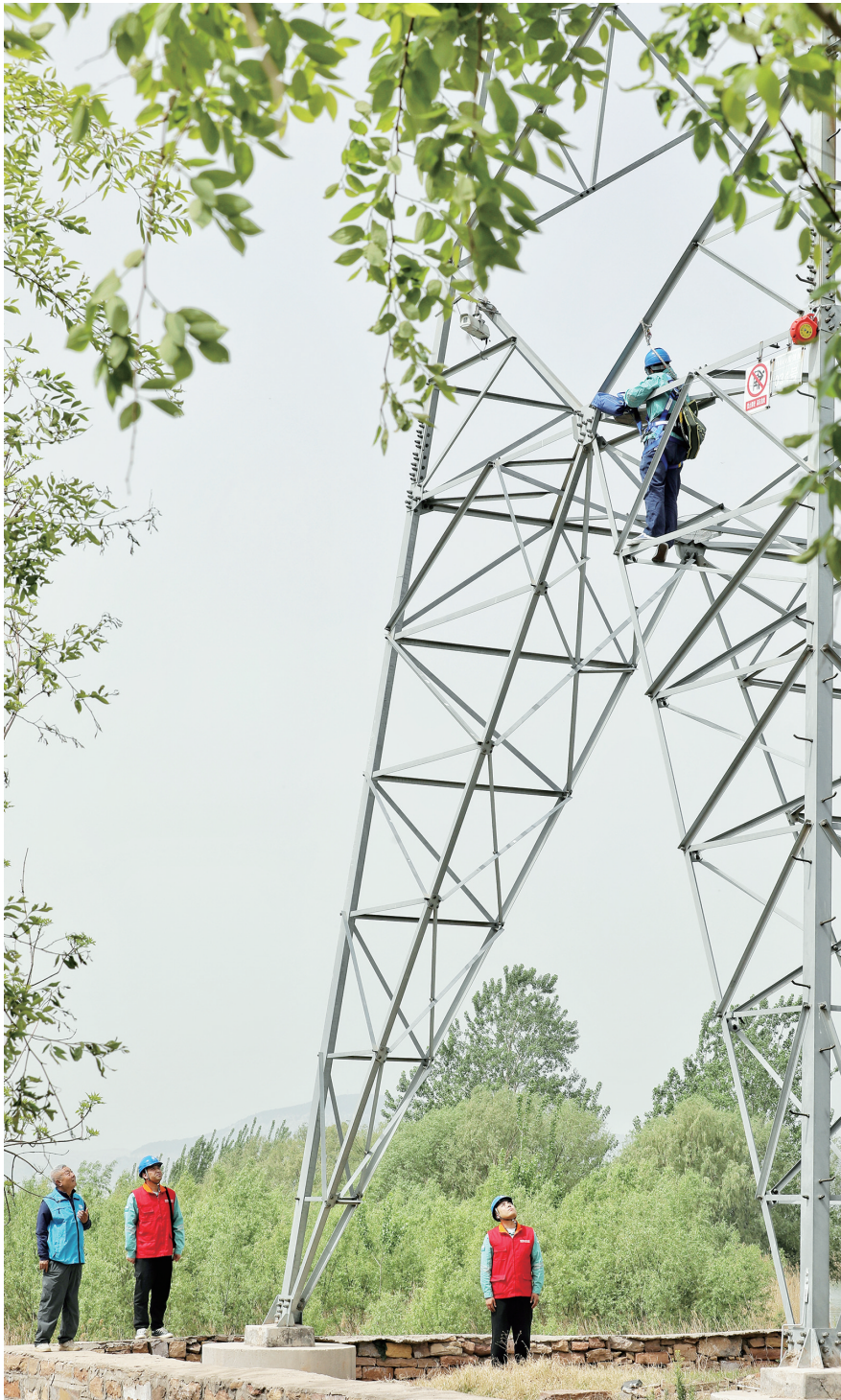
在电力铁塔合适的位置为鸟儿安置“新家”。
