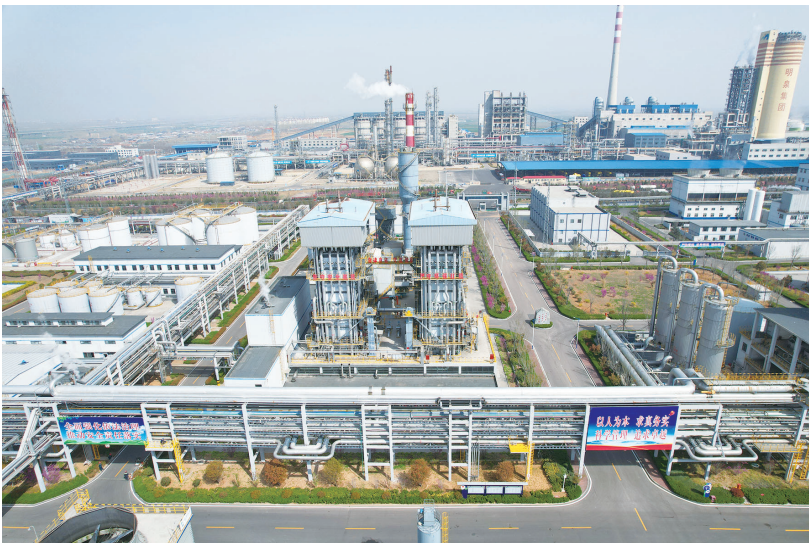
■宁阳化工园区架起的公用管廊将化工企业连成一个整体。 记者 隋翔 摄
