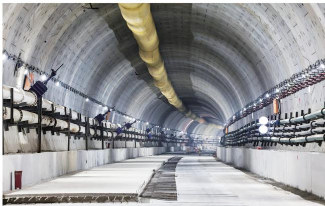
汕汕高铁汕头湾海底隧道盾构贯通段(3月26日摄)。当日,由中铁十四局承建的世界首条设计时速350公里单洞双线高铁海底隧道——汕(汕头)汕(汕尾)高铁汕头湾海底隧道成功贯通。该隧道全长9781米,最深处距离海面98.5米。
