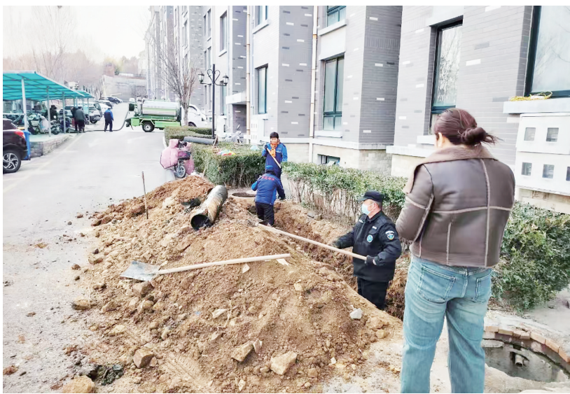
■社区翻新污水管道。
