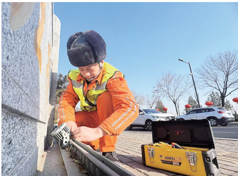
■路灯所工作人员检查灯具线路。
